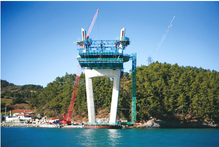
금오도안도 연도교 공사(2008년)
