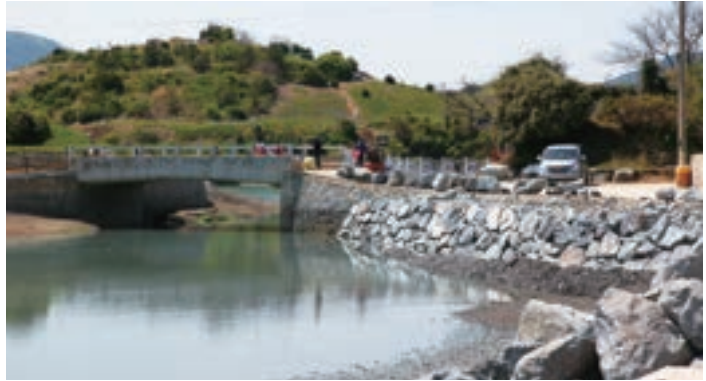
작은섬과 연결된 다리 / 석축을 쌓아 도로 확장 공사 중
